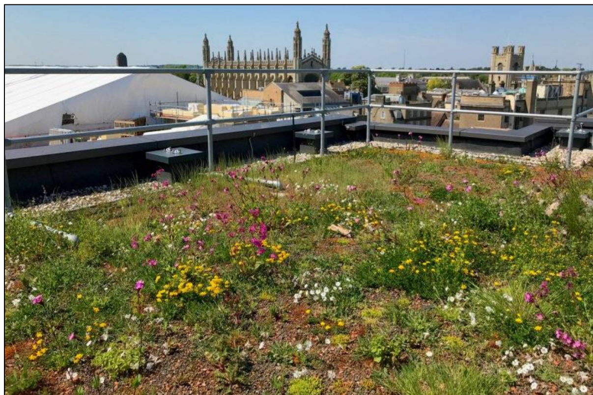
Figur 2.3. Taket på David Attenborough Building i Cambridge. Bildet er hentet fra https://livingroofs.org/
